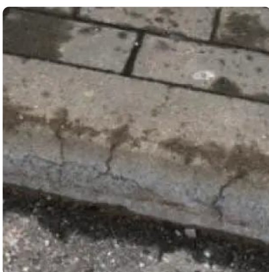
8.10 p. Bordiūrų paviršiaus išsikristalinimai
