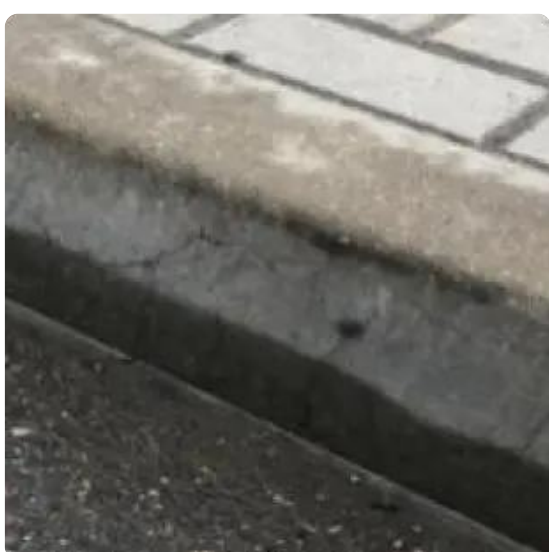
8.10 p. Bordiūrų paviršiaus išsikristalinimai
